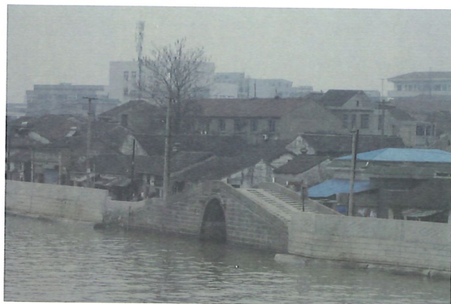
修缮后的万福桥、万安桥
